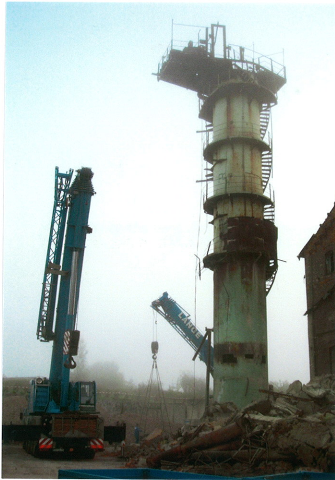
Zuckerfabrik Tessin - Rückbau eines Kalkofens
